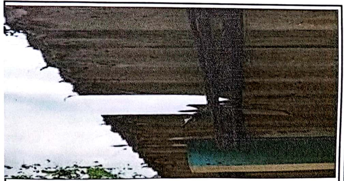
Foto 6: Cambio de techo
