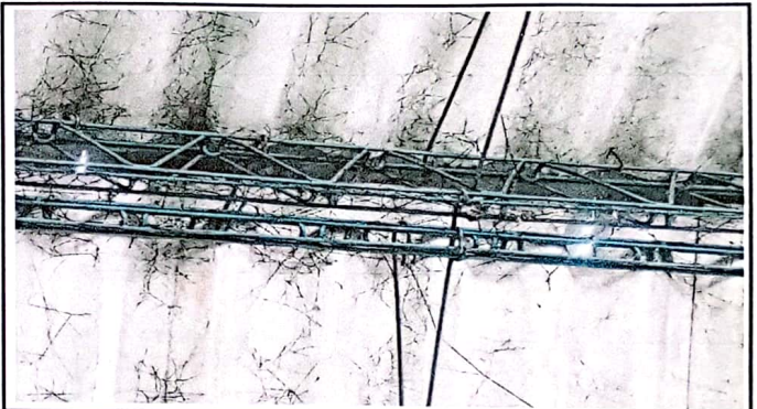
Foto 4: Sustitución de estructura
