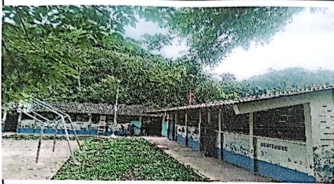
Foto 1: Cambio de techo
