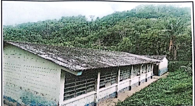
Foto 2: Cambio de techo
